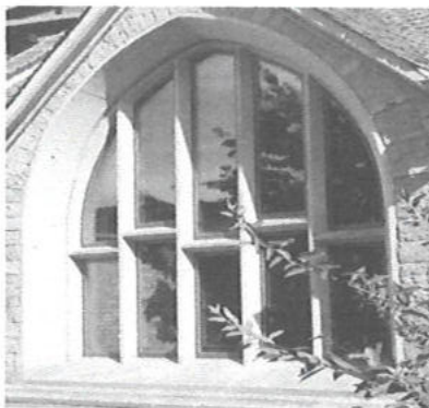
2011: Denkmalgeschützte Bleiglasfenster des Konfirmandensaals mit modernen Isolierglasscheiben als Vorfenster
